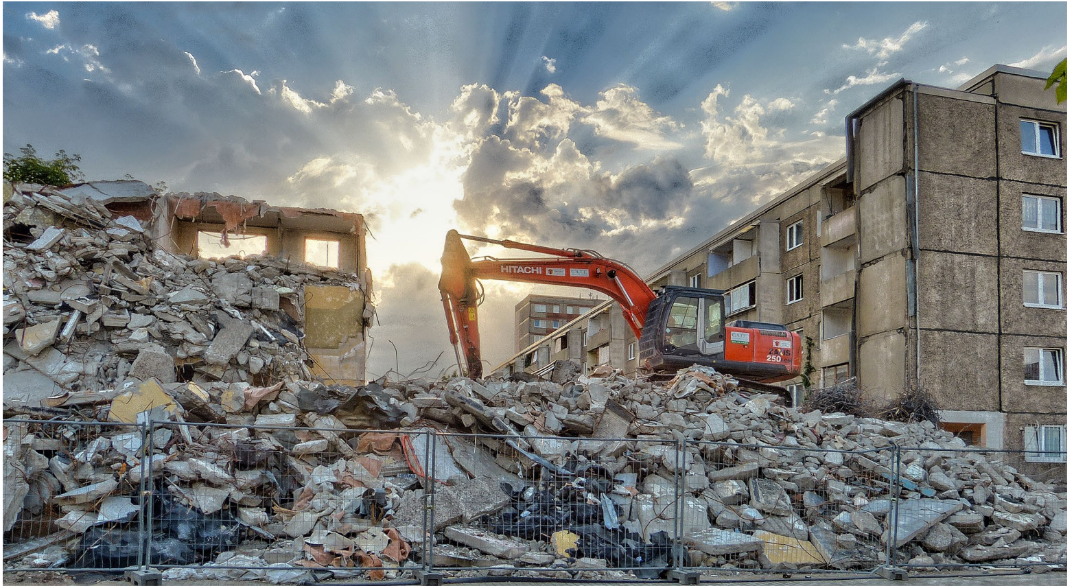
Platte platt gemacht Abrissbagger in der Bauhofstraße. Foto: Frank Spyrka
